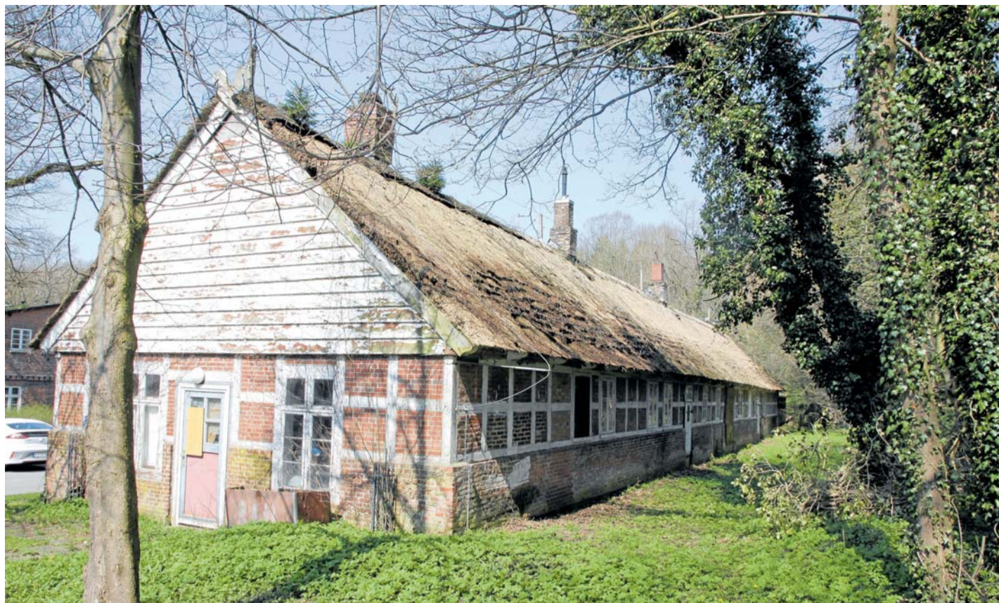
Viel hat sich noch nicht getan auf Hof Hammer. Der Baubeginn für das neue Wohnquartier könnte sich weiter verzögern. FOTO: MARTIN GEIST
